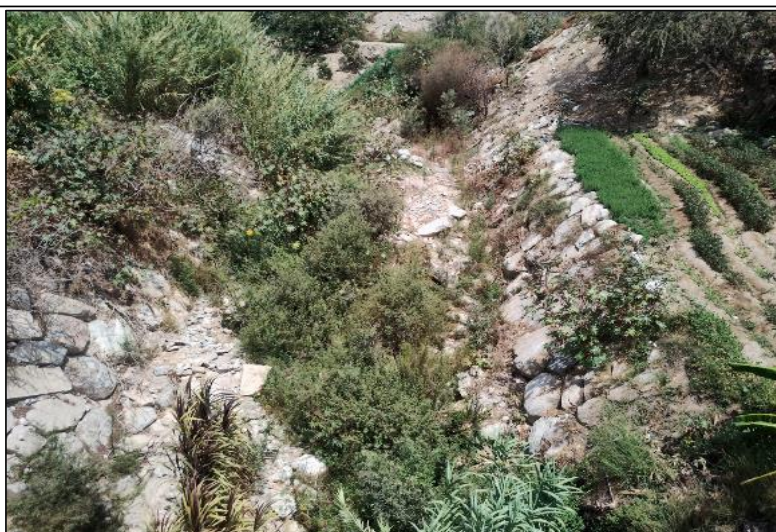
FIGURA N°02: CAUCE DE LA QUEBRADA HUANCANO, SE OBSERVA COLMATADO.
